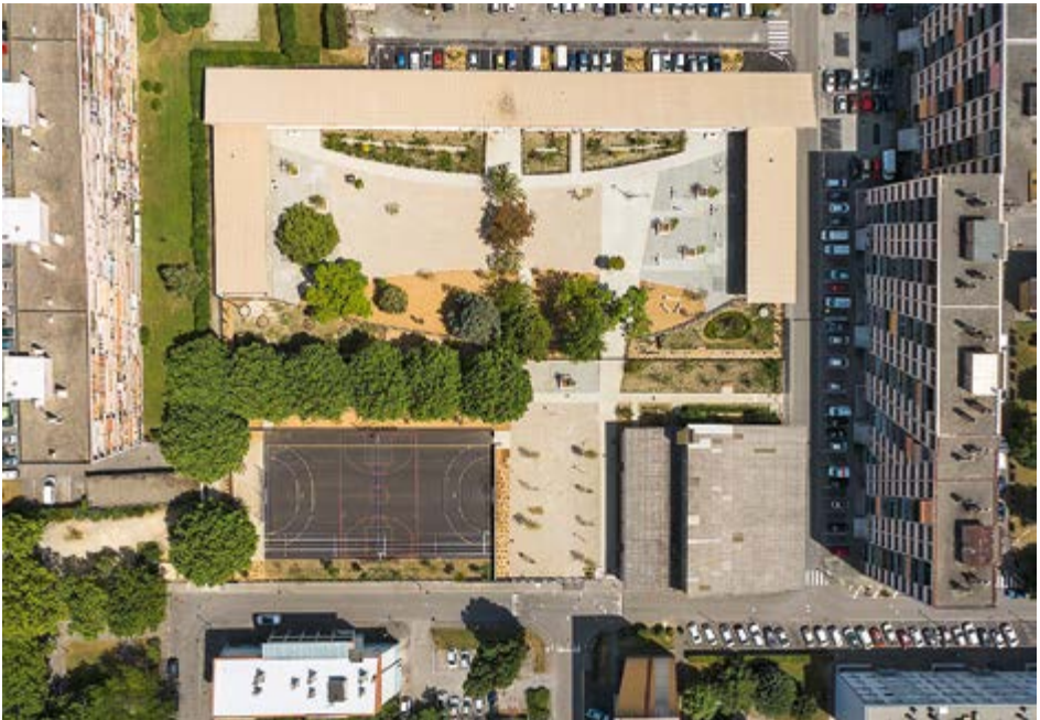
Figure F 14 : Vue aérienne de l'îlot Marcel-David après les travaux (juin 2022).
