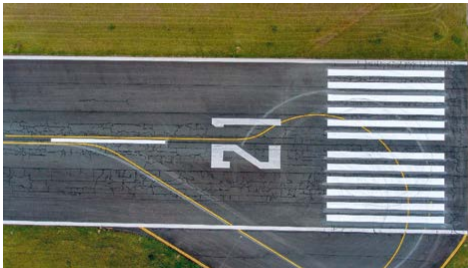
Figure C 41 : Vue aérienne d'un seuil de piste.
