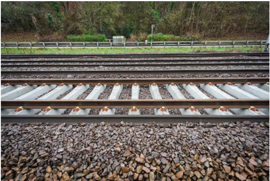
Figure F 15 : Voie ferrée avec traverses en béton.
