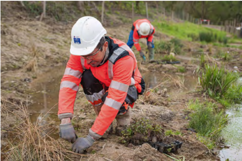
Figure D12 – Travaux d'aménagement de cours d'eau autour de l'autoroute A63.
