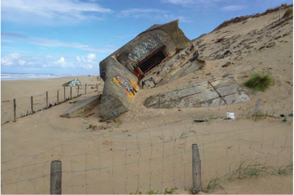
Figure G3 – Construits sur le sommet de la dune durant la Seconde Guerre mondiale, les blockhaus basculant sur la plage sont des témoins incontestables du recul du cordon dunaire.
