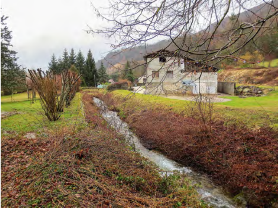
Figure F2 – Cours d'eau dégradé (rectiligne) menaçant une habitation en cas de crue.
