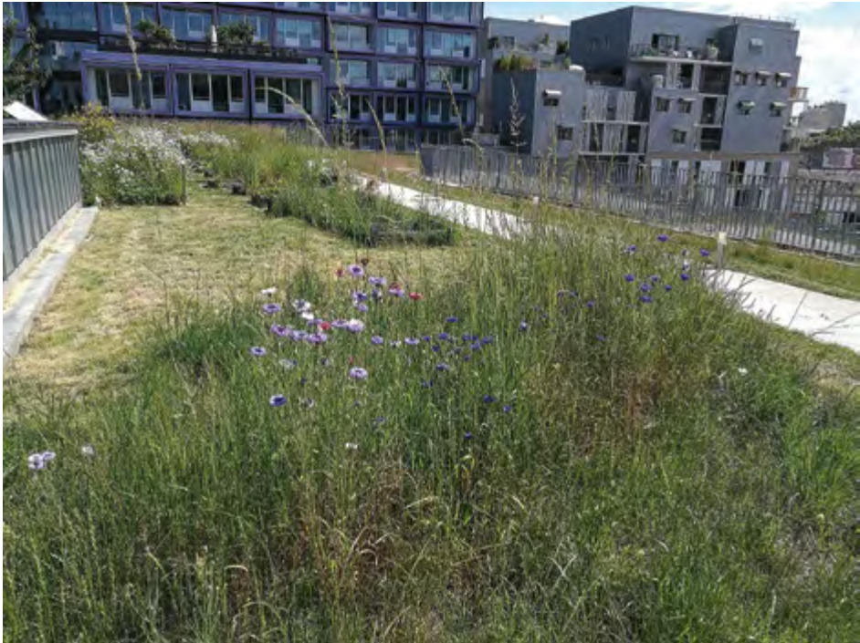
Figure E10 – La toiture végétalisée de l'école des sciences et de la biodiversité à Boulogne-Billancourt.
